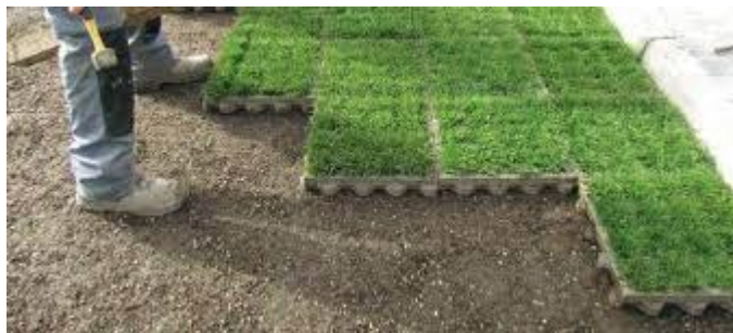
Figure 3 : Installation des dalles alvéoles engazonnées [10]
