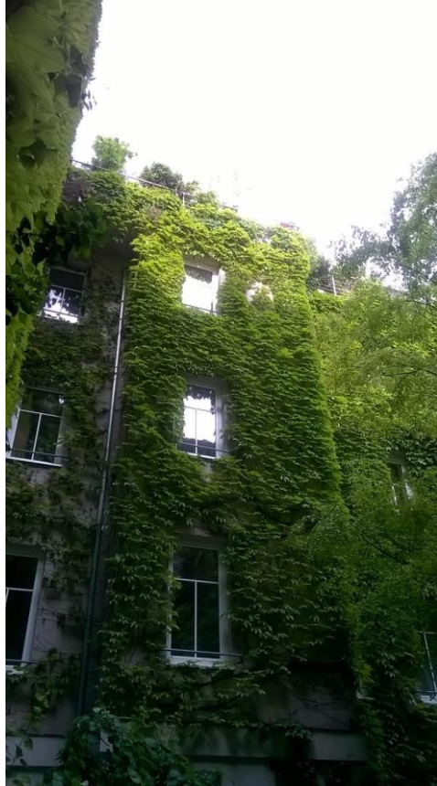
Façade végétale de grimpantes, Vienne (source M. Musy)
