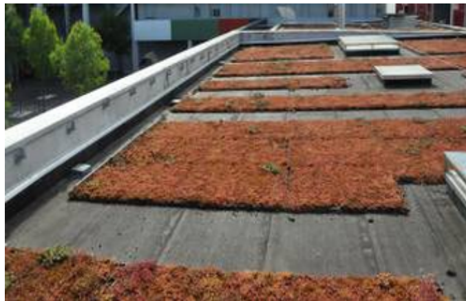
Toiture végétalisée du groupe scolaire
