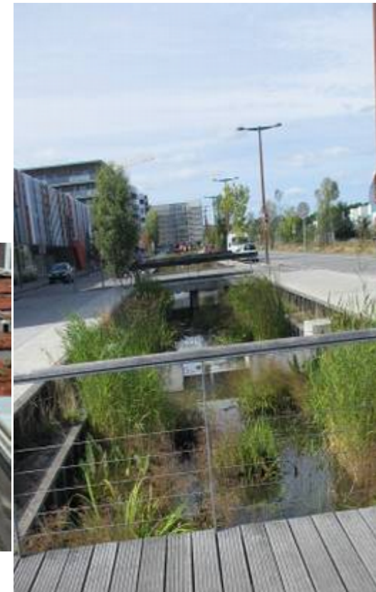
Canal de rétention
